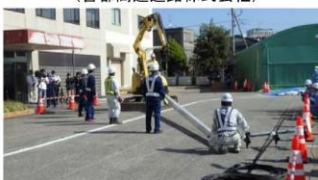
バックホウによる電柱撤去
