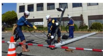
ケーブル撤去（東京電力・NTT 東日本）
