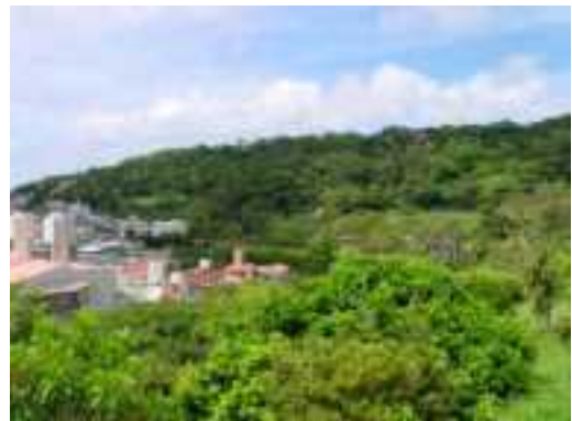
イメージ写真（斜面地部分）
