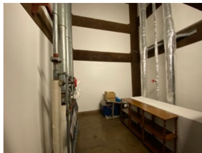
写真 5.22：ドレンチャー及びスプリンクラーの配管
