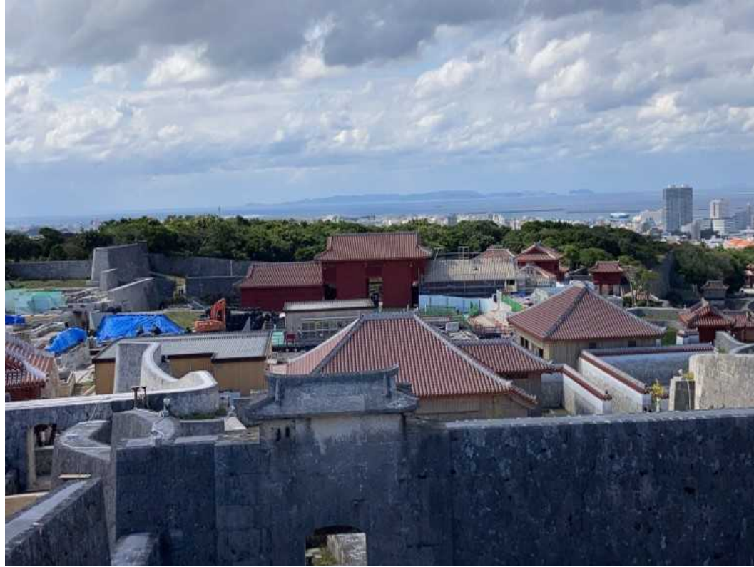
東のアザナより正殿方向を見る R3.1.10撮影
