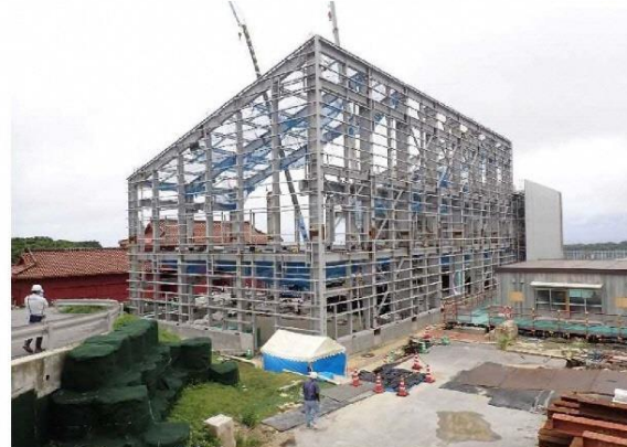
建方工事の状況
