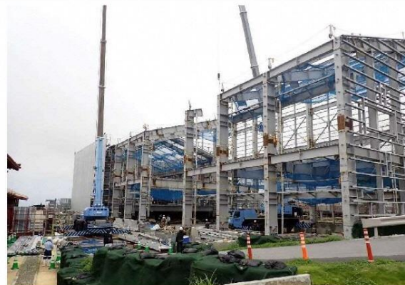
建方工事の状況
