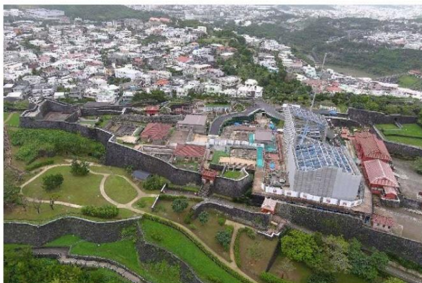
建方工事の状況(北側より)
