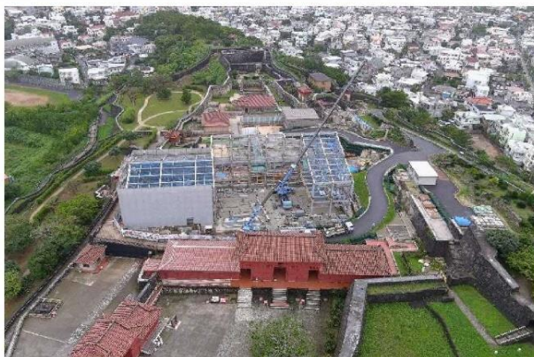
建方工事の状況(西側より)
