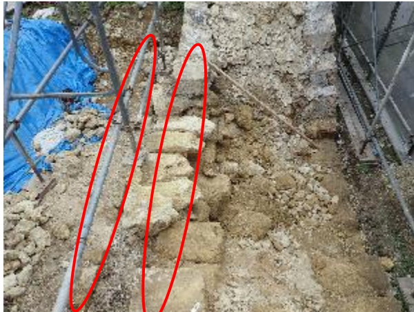
石積み遺構②（水路遺構）
