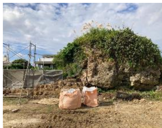
状況写真③
