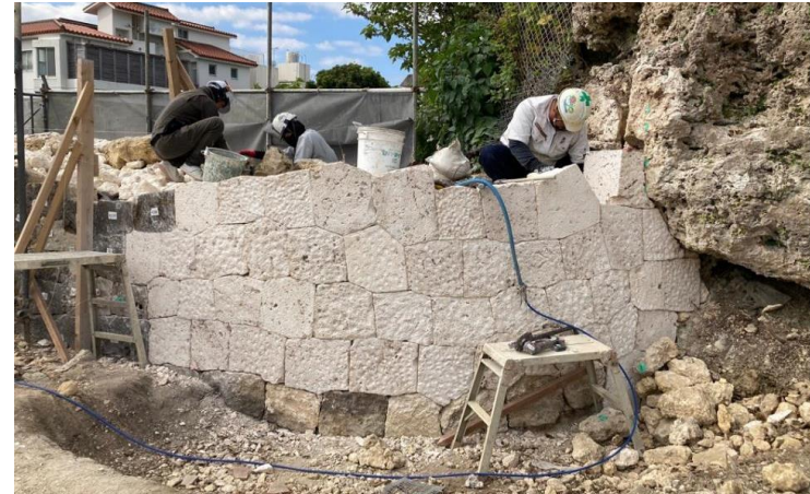
【施工状況写真】
