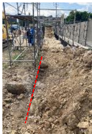
状況写真①
