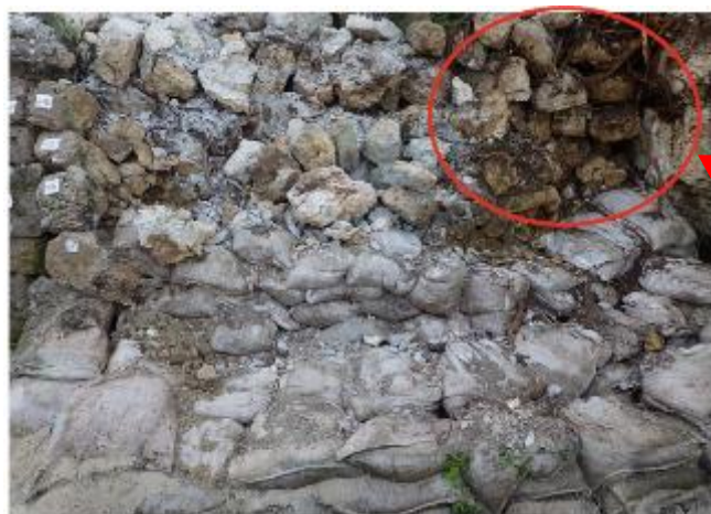
土のう撤去中
