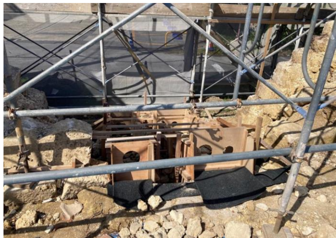
管防護工型枠設置状況写真
