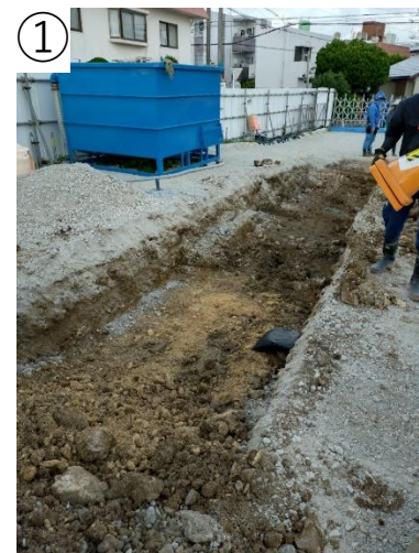
舗装面と石積み
