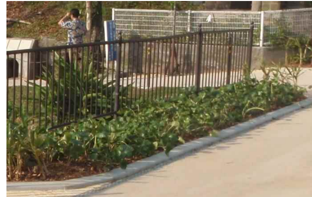
▲安全柵と植栽の事例（首里城公園）
