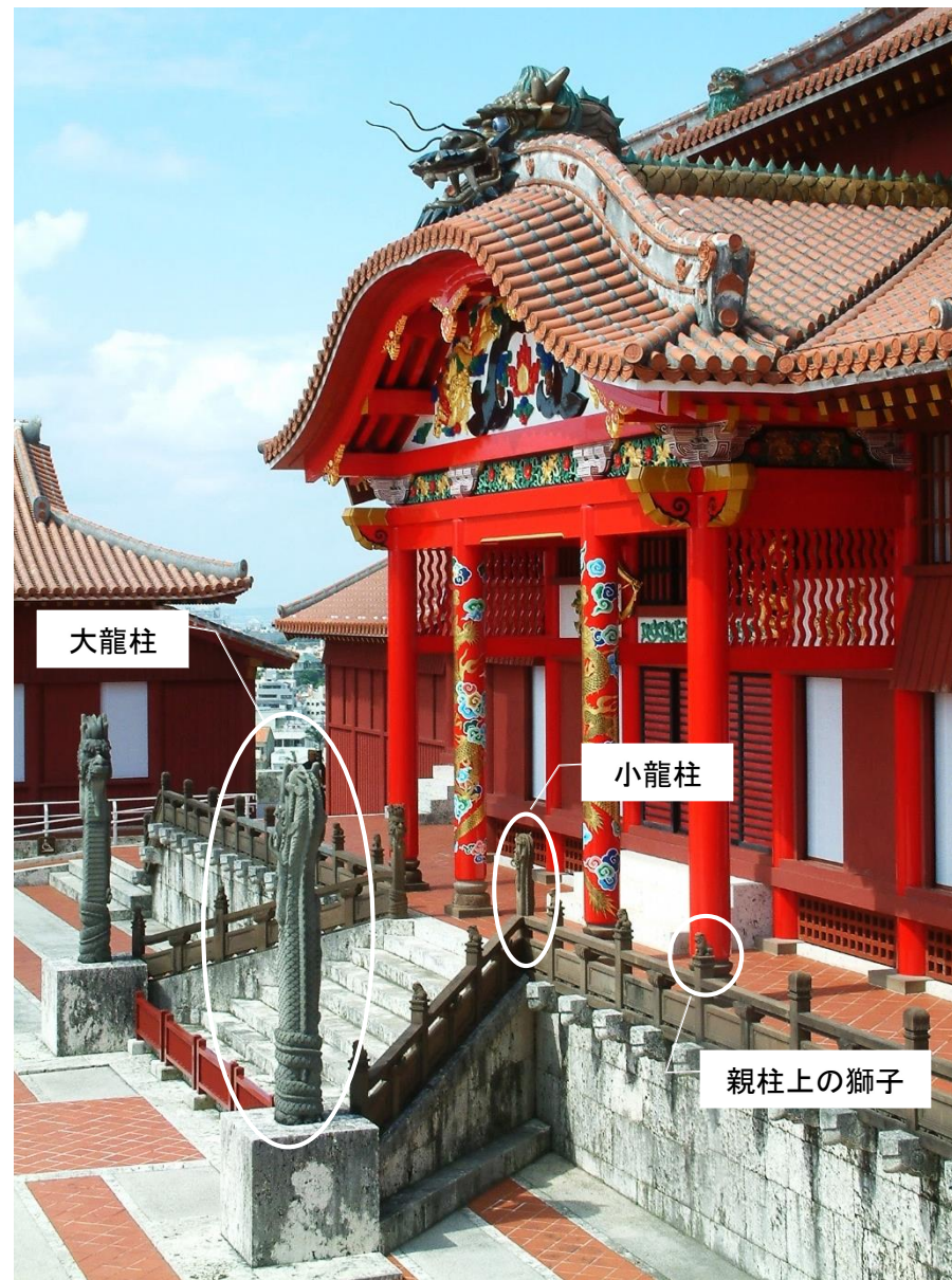
平成復元時の写真（正殿唐破風）（（一財）沖縄美ら島財団提供）
