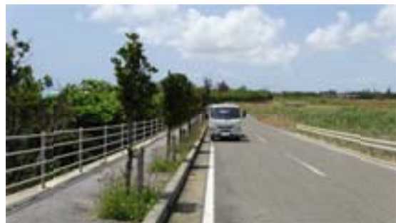
街路樹足下の雑草の繁茂
