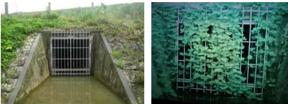
図 5.47 ボックスカルバート西側出口
