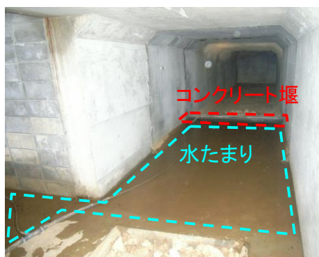
コンクリート堰
