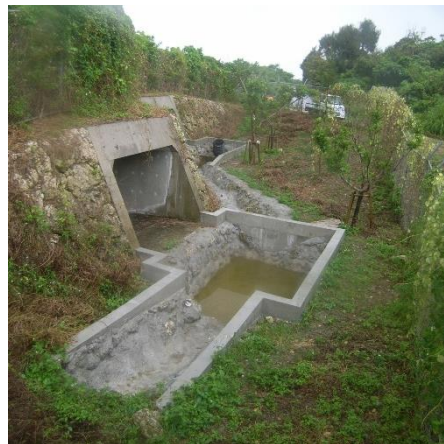
洞口前面のに設置した池の止水工
