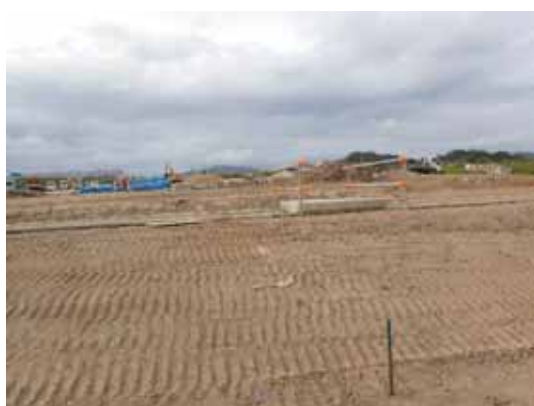
滑走路増設工事状況(平成30年11月)
