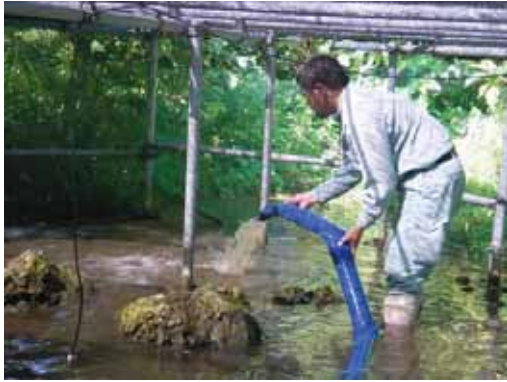
ポンプによる緩衝池内にたまった泥の攪拌、 排出
