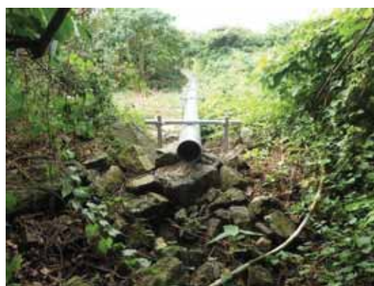
雨水切り回し水路(平成30年11月)
