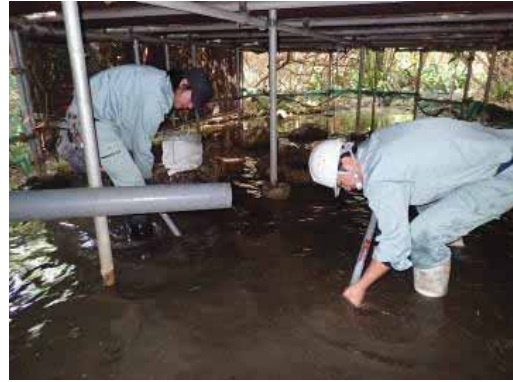
緩衝池内に流入した土砂の排出
