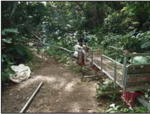
資材運搬用モノレール
