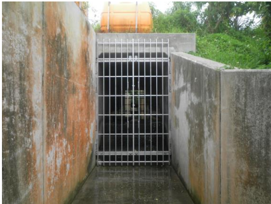
図 4.23 (1) ボックスカルバート出入口 (平成 28 年 3 月 22 日設置)
