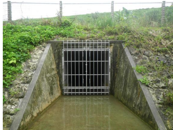
図 4.23 (1) ボックスカルバート出入口 (平成 28 年 3 月 22 日設置)
