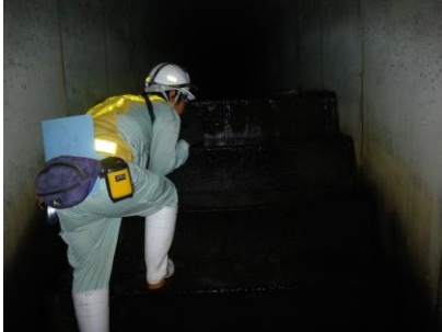
カルバート内踏査
