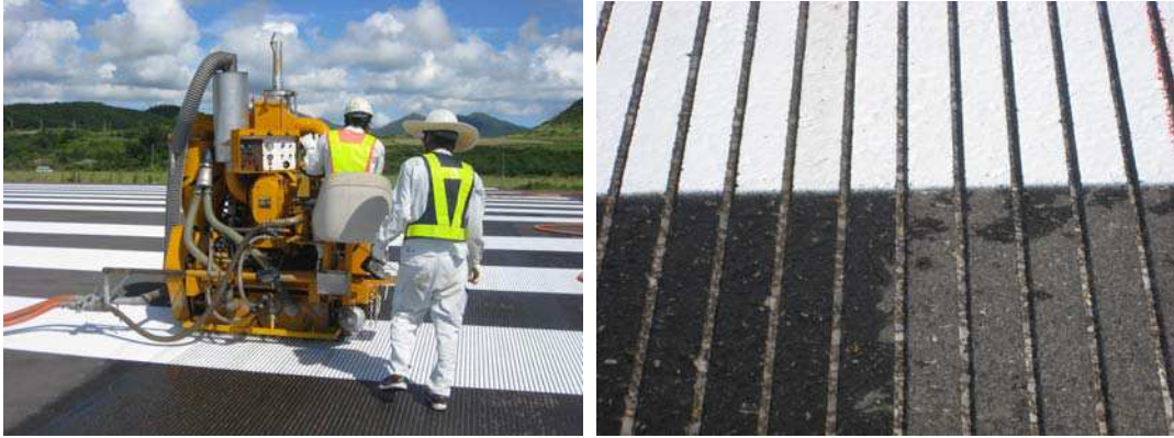
図 2.4.1 グルーピング工の施工状況
