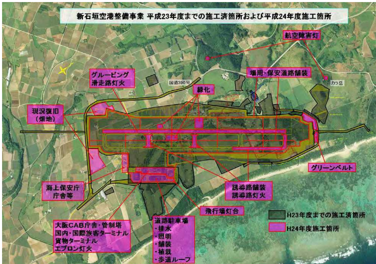
図 2.1.1 平成 24 年度工事箇所
