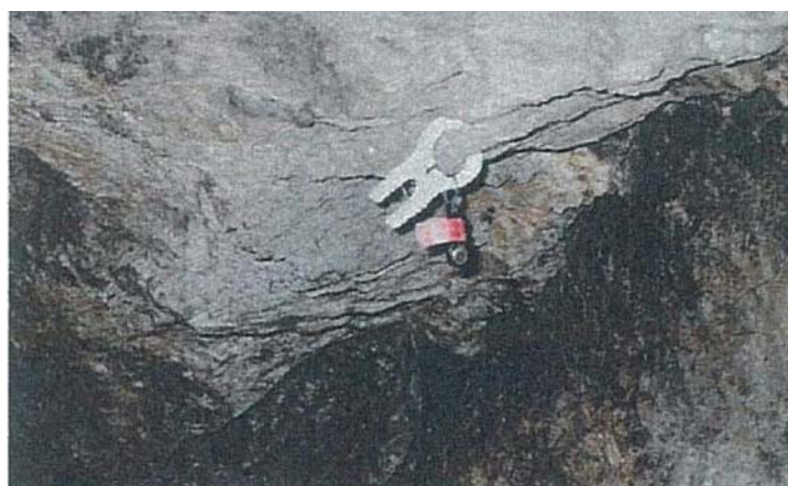
図 5.3 環境測定器設置状況
