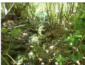
水路部の状況 (平成 28 年 8 月)
