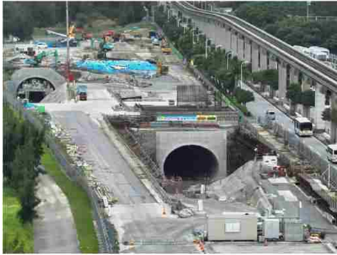
小祿道路（赤嶺トンネル）（国事業）
