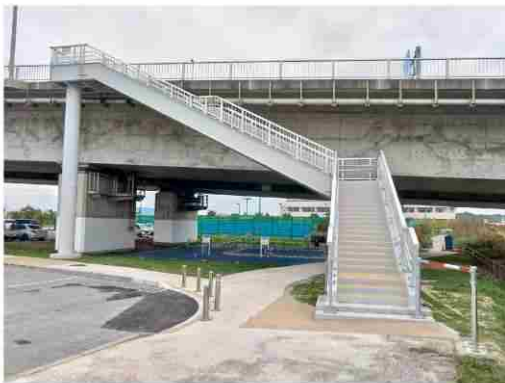
豊崎地区の緊急避難階段（国事業）
