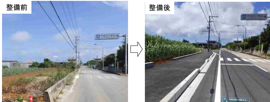
一般県道 長山港佐良浜港線 歩道設置
