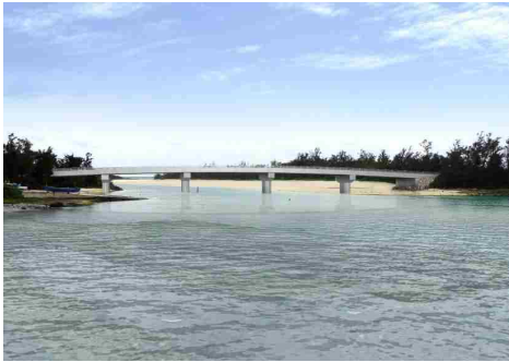
一般県道平良下地島空港線(乗瀬橋)
