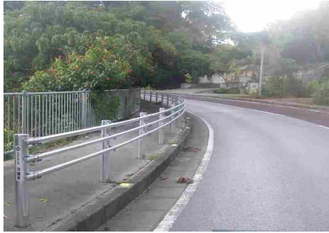
防護柵(ガードパイプ)
