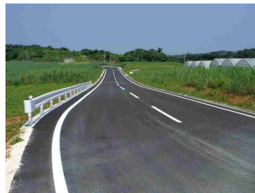
久米島町道久米島縦断線
