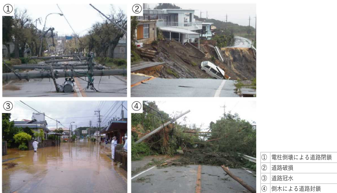
図 2-31 台風による道路及びその他被害状況
