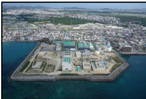
【宜野湾浄化センター】
