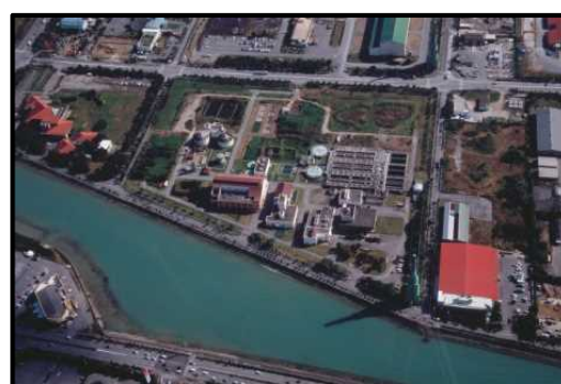
【具志川浄化センター】
