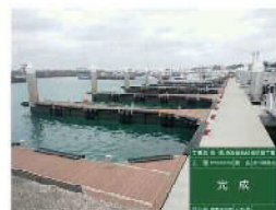
改良後（浮桟橋）
