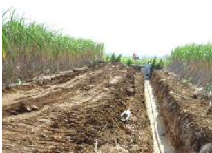
管路の布設作業
