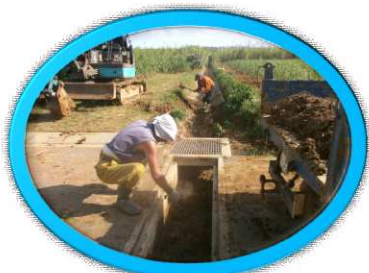
側溝の泥上げ清掃
