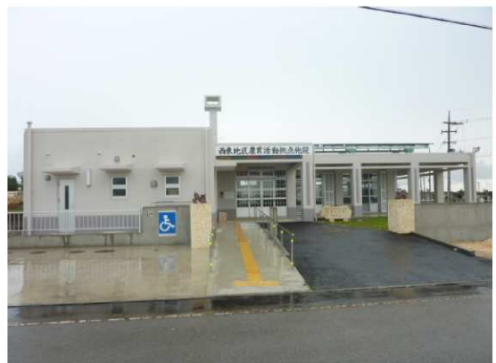
地域農業活動拠点施設整備(西東)
