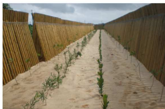
農地保全整備事業（防風施設）
