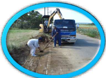
側溝の泥上げ清掃
