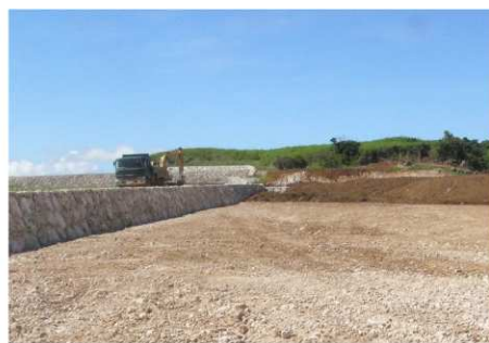
区画整理工事の様子
