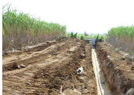
管路の布設作業
