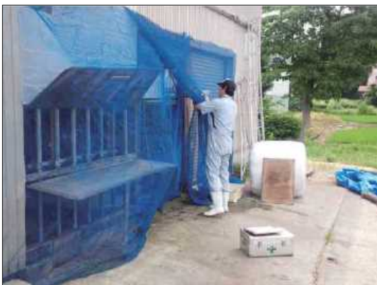
農場周囲に防虫ネットを設置
