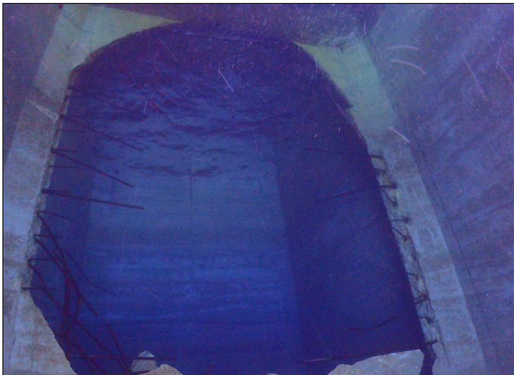
隔壁が破損して、2番目の隔室の中詰め材が流出している状況
