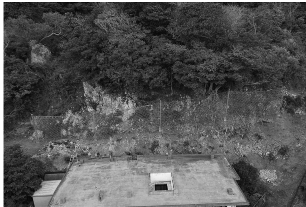
緊急予防治山（南城市）
