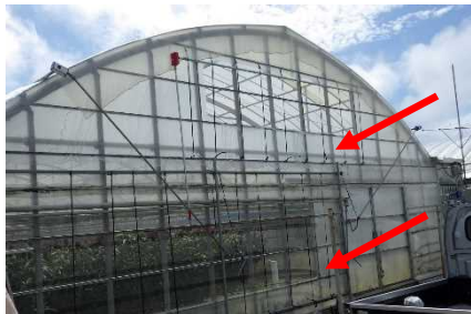
妻面ビニールは空けられるように工夫され、前方のネットを目合いの大きいものに変更し、風通しをよくしている事例
