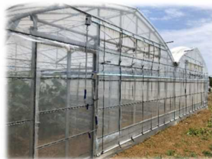
巻上機を2段に設置
