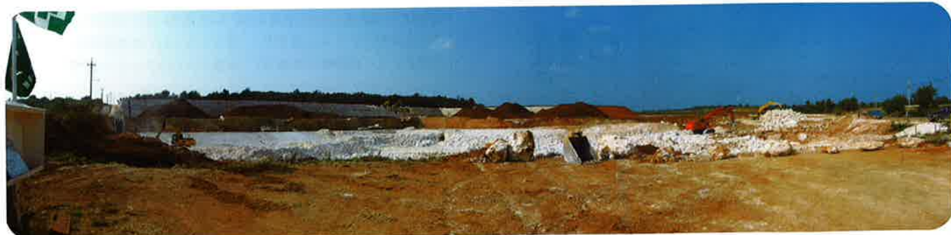
さとうきび増産に向けて、ため池工事が着々と進む(工事中のため池)
