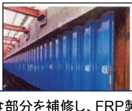
腐食部分を補修し、FRP製カバーによる腐食防止対策
