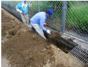
排水路の土砂上げ
