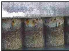
腐食が進行した鋼管式防波
