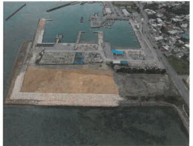
水産流通基盤整備事業 平敷屋地区
