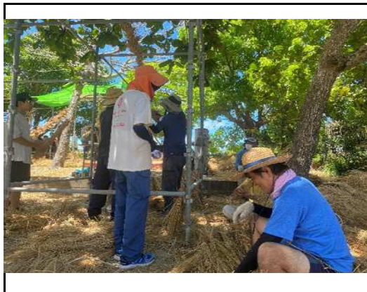
(足場を組んだ綱力キに参加した住民)
