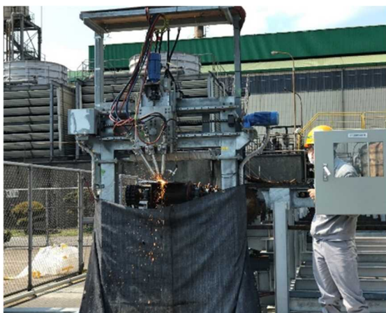
図5 完成した自動切断装置
