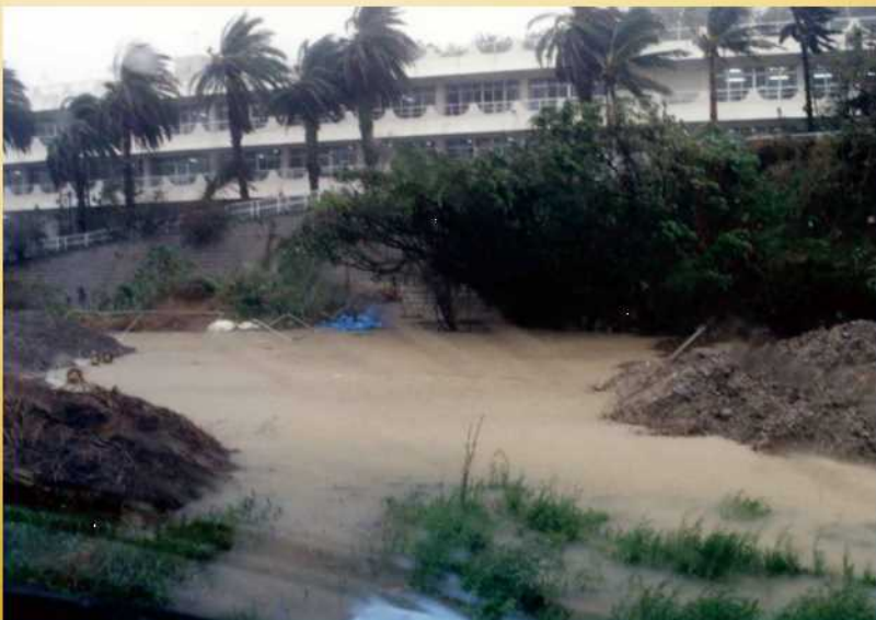
台風による現場冠水
