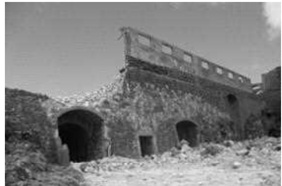
燐鉱石貯蔵庫 近景
