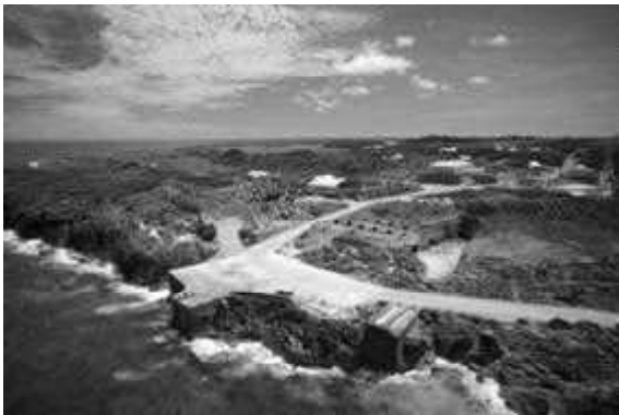
燐鉱石貯蔵庫 遠景
