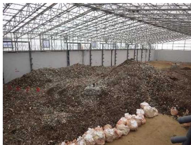
写真3. 屋根付き埋立地の内部
