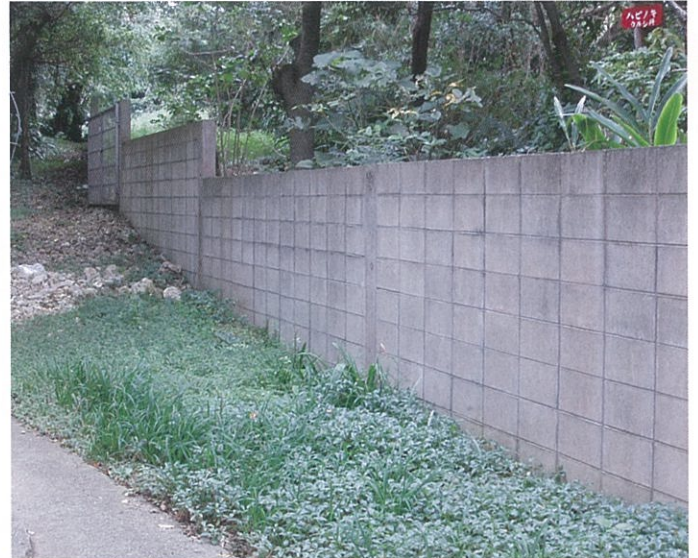
ハブの侵入を防ぐブロックべい
