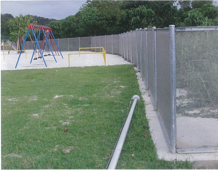
ハブの侵入を防ぐフェンス
