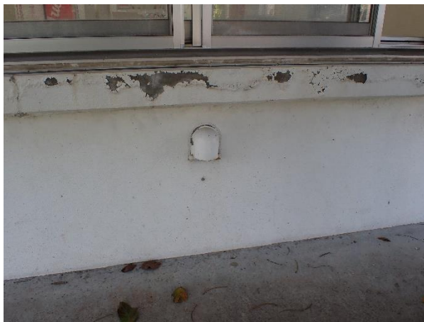
建物壁の通気口
