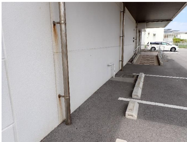
排水管横で確認した場所
