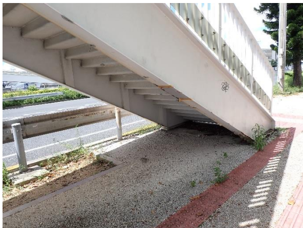
那覇軍港（周辺）：陸橋下で確認した場所
