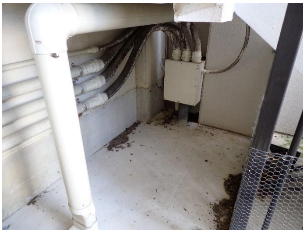
建物隙間で確認した場所
