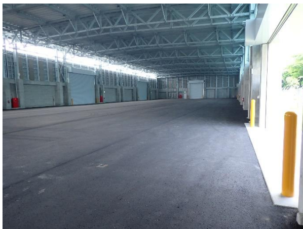
那覇港：新しい倉庫内で確認した場所
