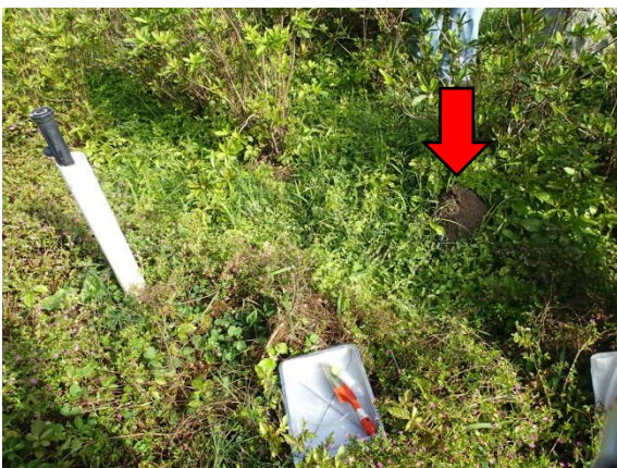
スプリンクラー近くでは蟻塚が大きくなっている
