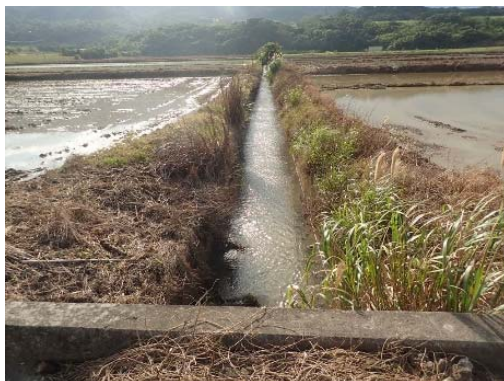
宮良川河口 水田から濁水流出 (H30 年度)
