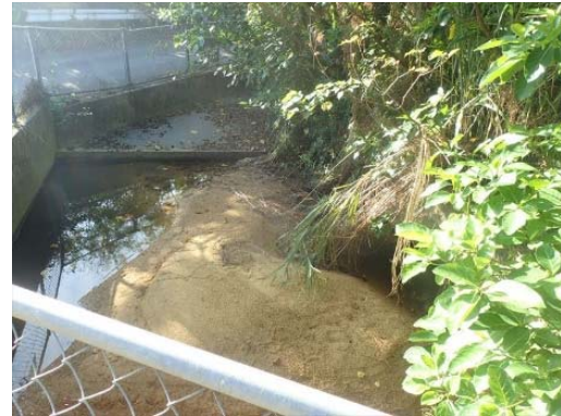
野崎川河口 集水柵に土砂が堆積 (今年度(H31 年度))
