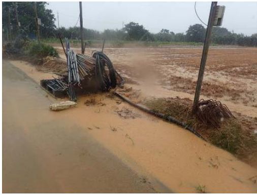
大井川(今帰仁村)河口 裸地から濁水流出 (今年度(H31 年度))
