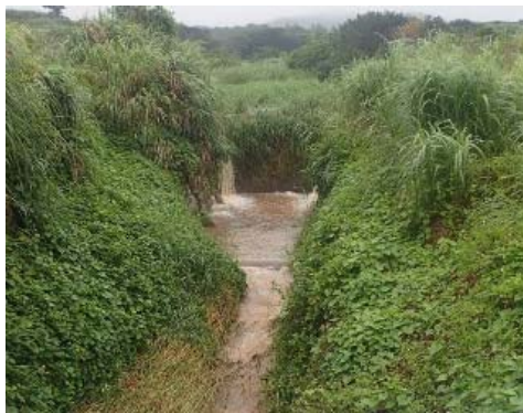
儀間川河口 沈砂池からの濁水流出 (今年度(H31年度))
