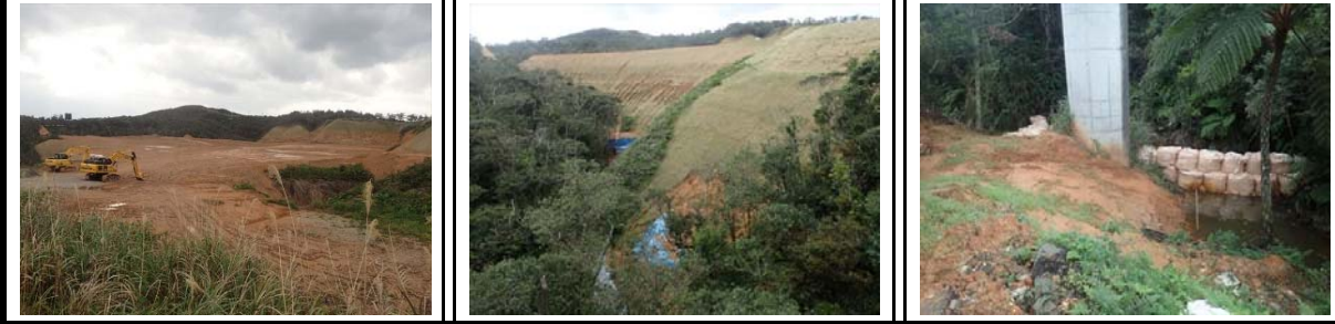
⑫ 工事現場の状況
