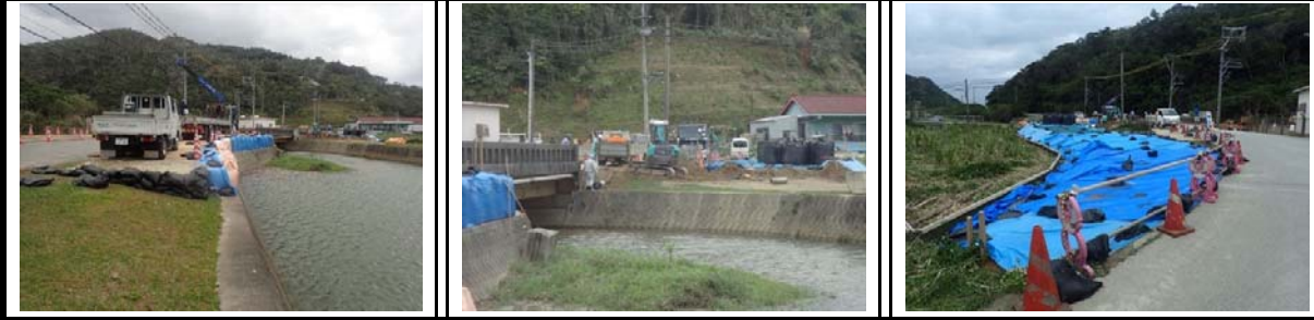
⑩ 工事現場の状況
