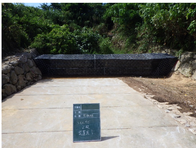
図-2.4.16 フトン籠の設置工程④(恩納村試験地)
