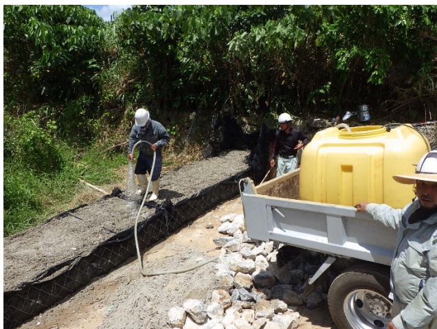
図-2.4.15 フトン管の設置工程③(恩納村試験地)
