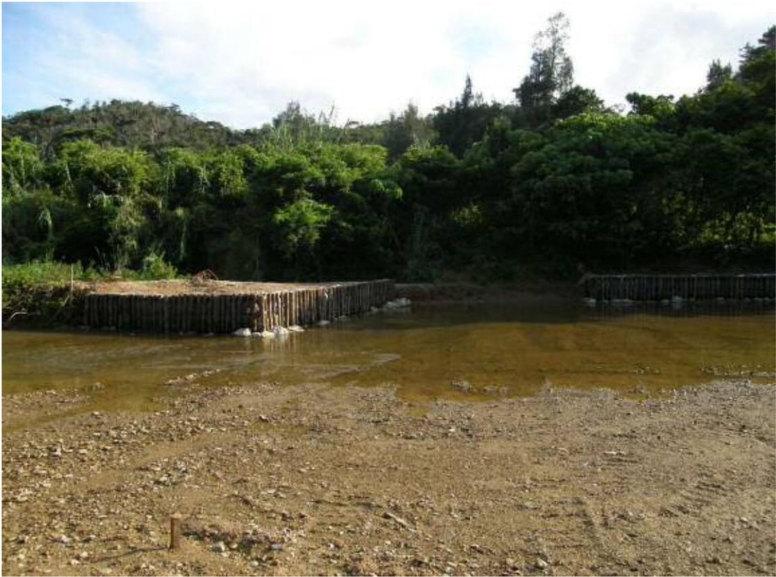
平成 29 年 7 月 18 日（改修直後：一部を杭で補強したほか、河岸に石を敷設）
