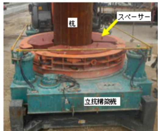
製作した杭径変更スパーサー
