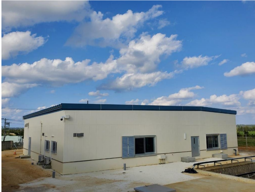
南大東浄水場 令和5年2月1日水道用水供給開始
